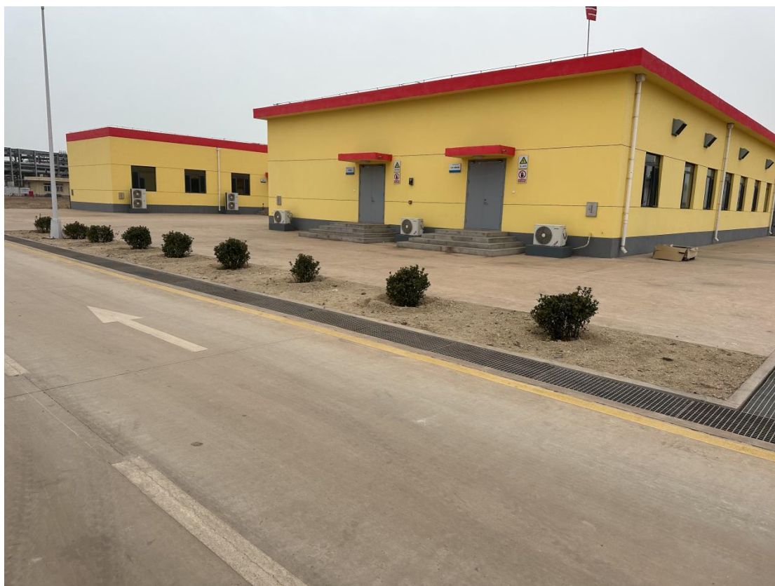
现场照片（10kV 变电所、综合用房）
