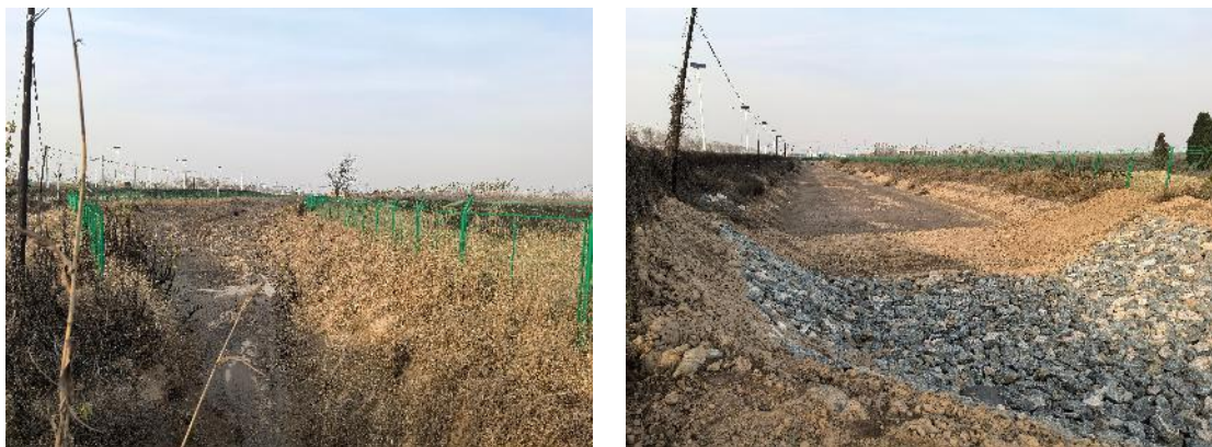
图2-10 校区西侧排洪渠现状
