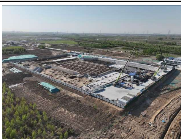
主体结构施工（2025.4）
