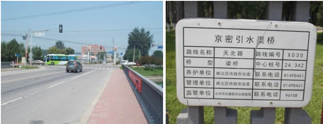
图 1-6 现状京密引水渠桥
