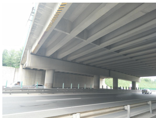
桥下道路现状图
