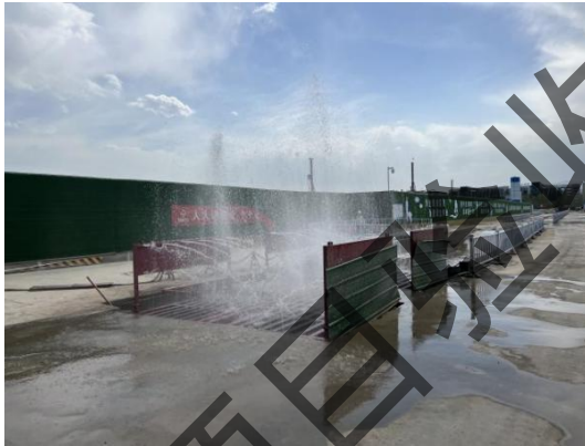
施工出入口洗车机 2023.6
