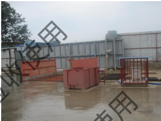
施工出入口洗车机及临时沉沙池
