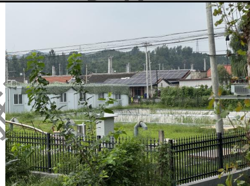
图 4-6 泵站工程区撒播草籽
