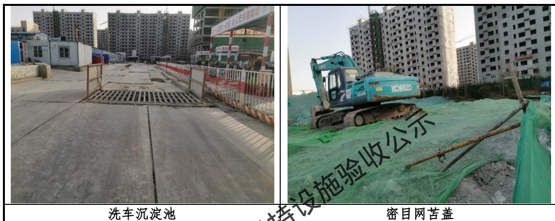
图 1-5 施工现场情况
