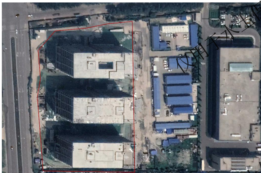
结构施工 2020年7月
