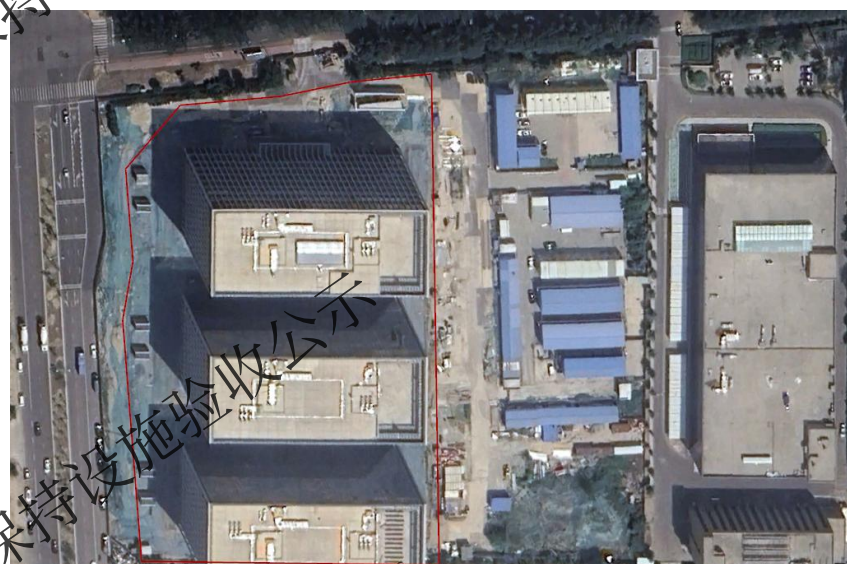
施工后期 2023年7月(无完工后更新)
