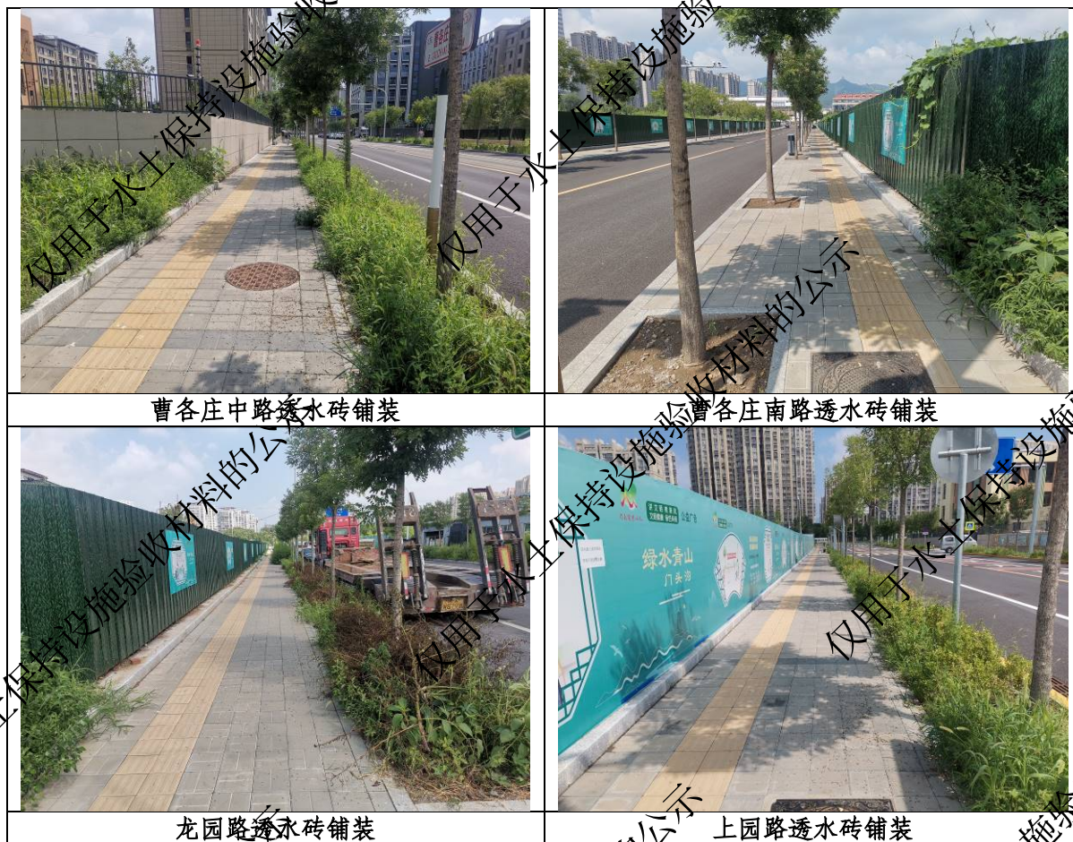
图 3-1 水土保持工程措施完成效果
