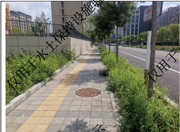
曹各庄中路透水砖铺装
