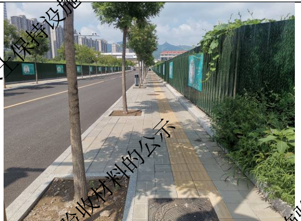
曹各庄南路透水砖铺装
