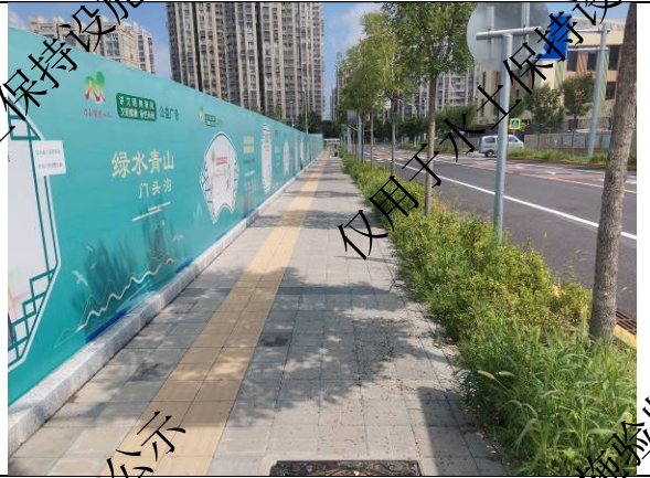
上园路透水砖铺装
