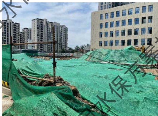
项目区临时苫盖（2026.6.26）
