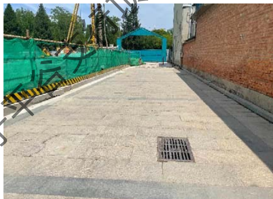
项目区临时排水（2026.6.26）
