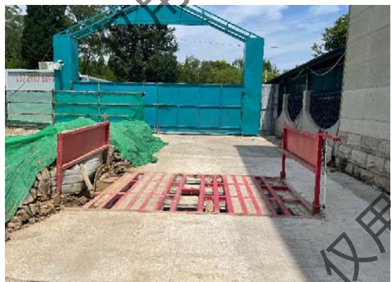
项目出入口洗车槽（2026.6.26）
