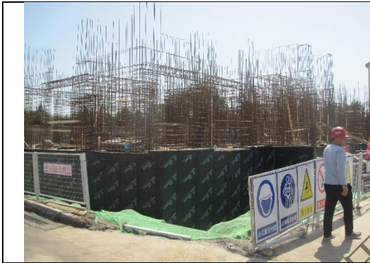
西地块主体结构施工 (2019.5.28)
