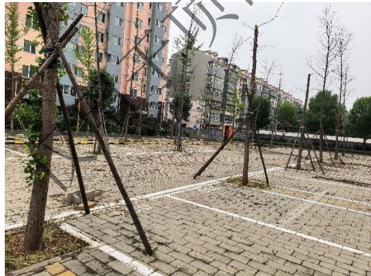
透水砖铺装（西地块）
