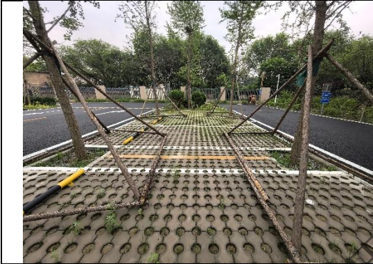
东地块植草砖铺装 (2026.5.15)
