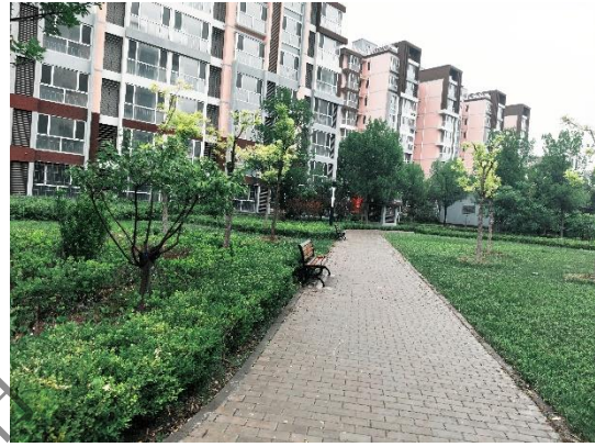
透水砖铺装（西地块）
