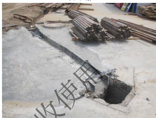
临时排水沟、沉沙池
