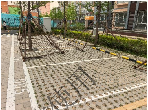
东地块植草砖铺装（2026.5.6）
