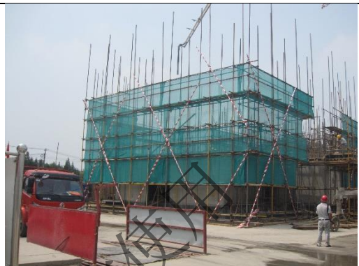
西地块主体结构施工 (2019.6.17)
