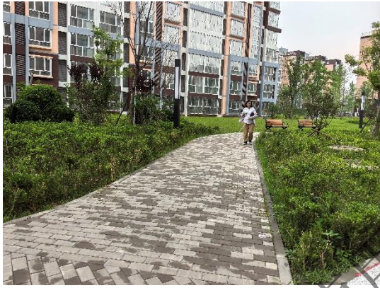
透水砖铺装（东地块）
