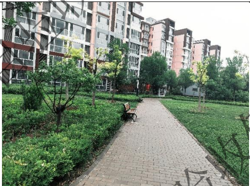
西地块透水砖铺装 (2026.5.15)
