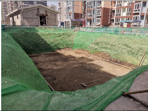
西地块小市政施工 (2021.4.26)
