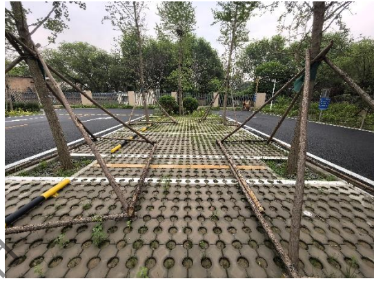
植草砖铺装（东地块）
