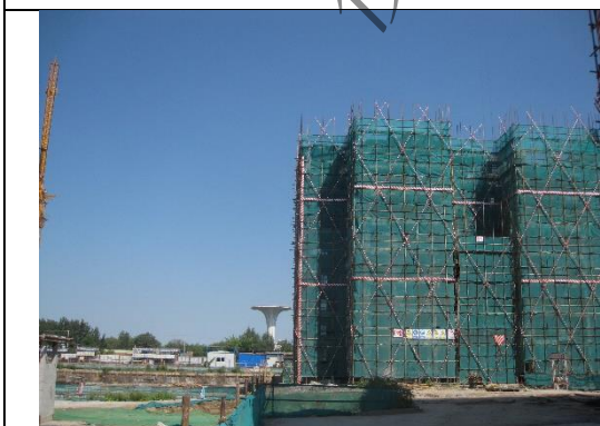
西地块主体结构施工 (2019.9.16)
