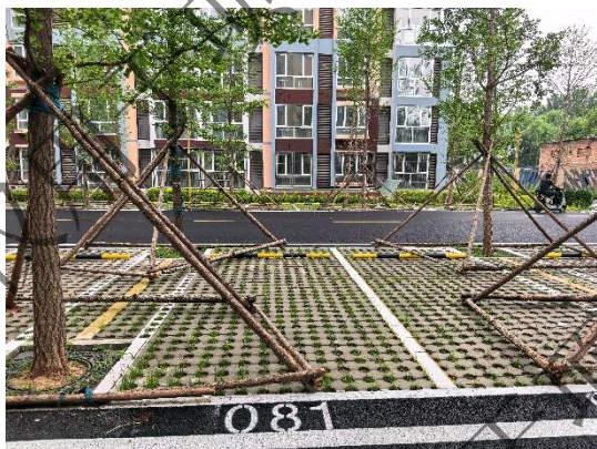
植草砖铺装（东地块）
