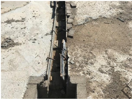
临时排水沟、沉沙池
