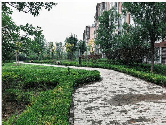
透水砖铺装（西地块）
