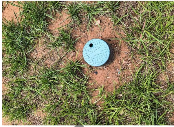
B 地块节水灌溉取水点
