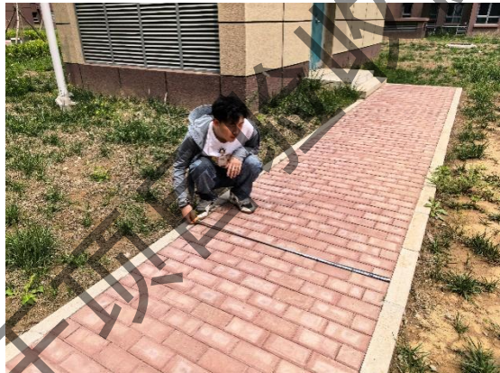
B 地块透水砖铺装
