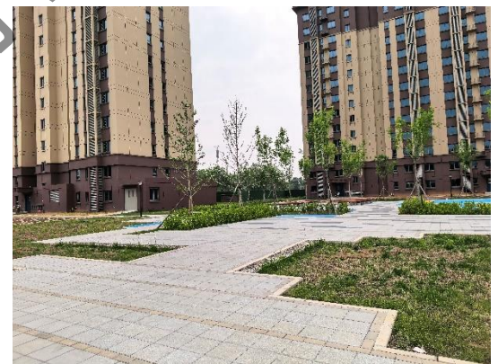
C 地块透水砖铺装
