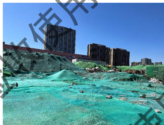
临时堆土密目网苫盖
