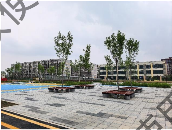
C 地块透水砖铺装
