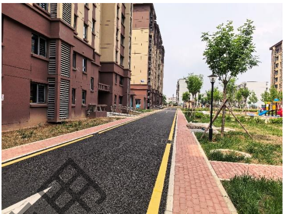
B 地块透水砖铺装
