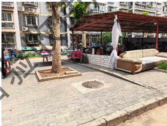
A 地块透水砖铺装
